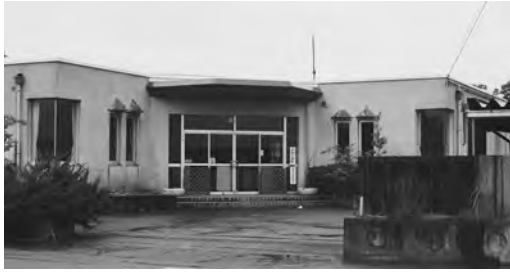
解体予定の旧上原保育所
