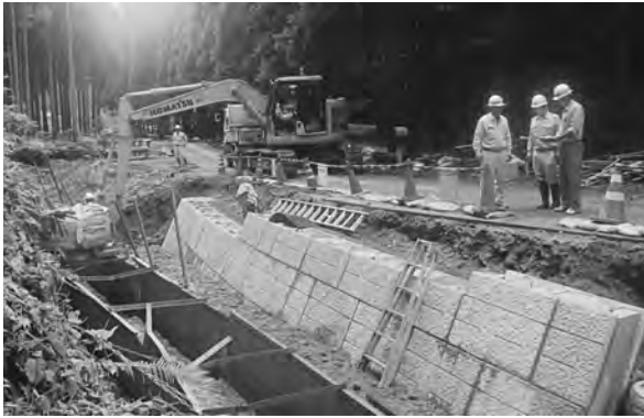
林道災害復旧工事現場の監督状況
