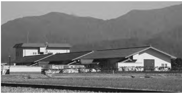
入善浄化センター
