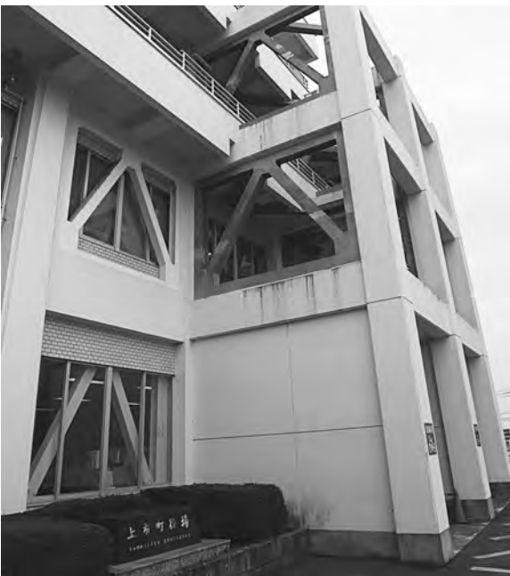
耐震補強された上市町庁舎
