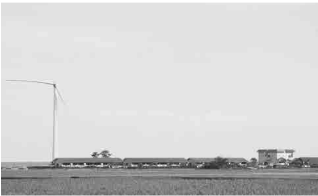
入善浄化センター
