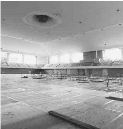
改修が始まった総合体育館
