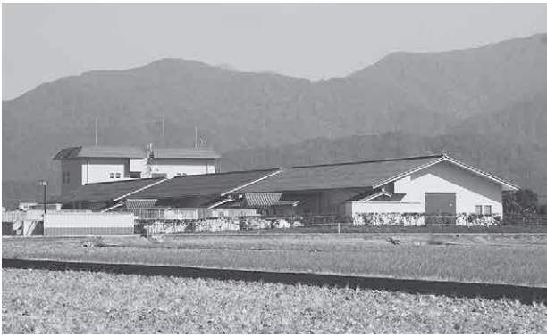
入善浄化センター
