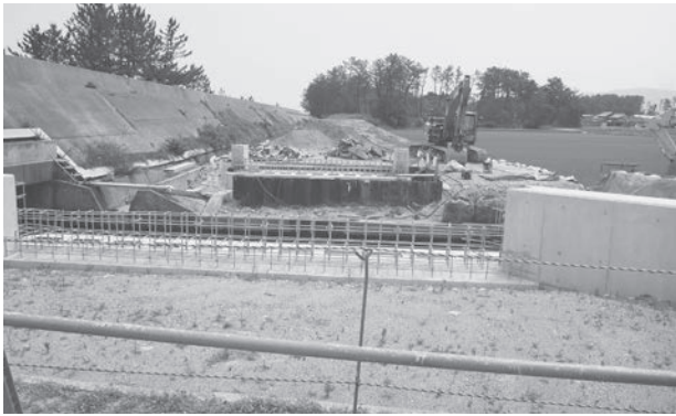
施工中のシーサイドロード（仮称）
