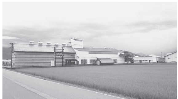
堆肥等保管施設に改修
