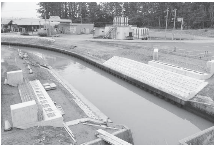
工事が進む漁港関連道
