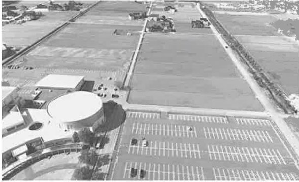
新庁舎建設予定地
