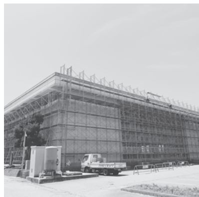
工事中の入善小学校体育館
