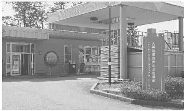
早期の完全復旧が望まれる深層水施設
