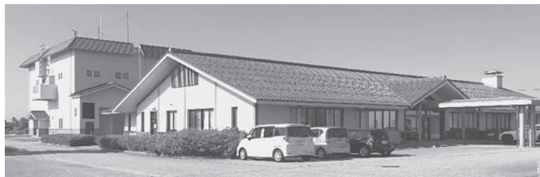
入善浄化センター
