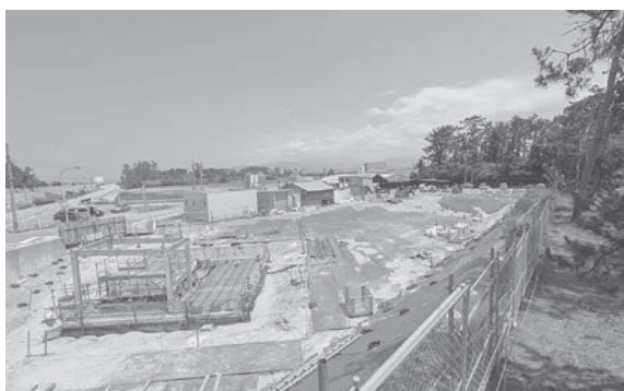
着工している取水棟工事
