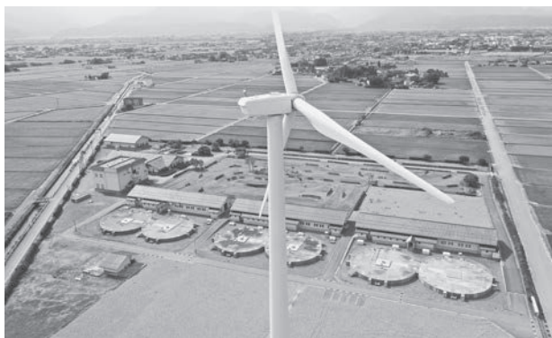
浄化センター全景と風力発電施設
