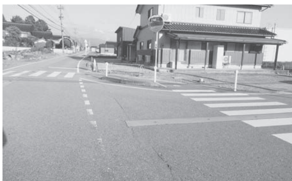
歩道整備のための解体が進む
