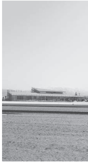
建設中の保育所
