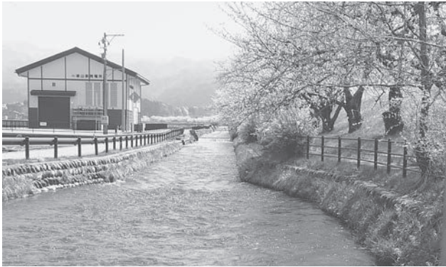
桜に映える浦山新発電所
