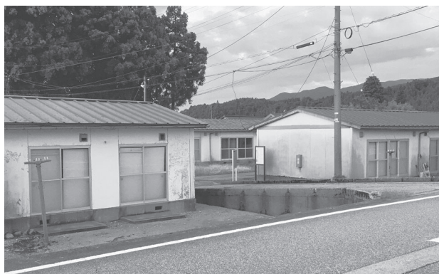
建設から 50 年以上経過した舟見町営住宅
