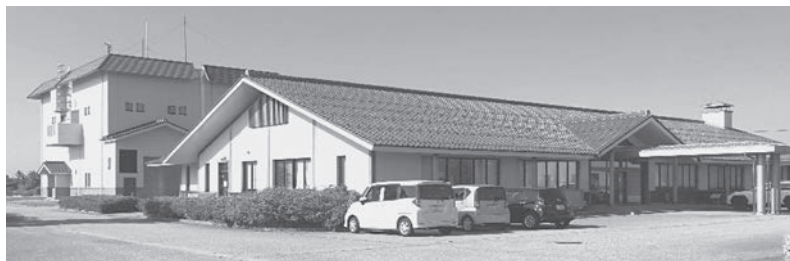
入善浄化センター
