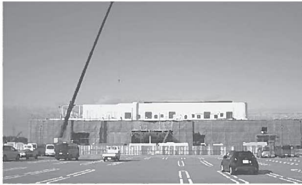
3月竣工に向けて作業が急がれる役場新庁舎
