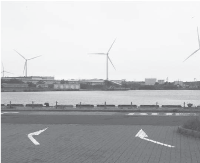
秋田港湾内から望む風力発電設備
