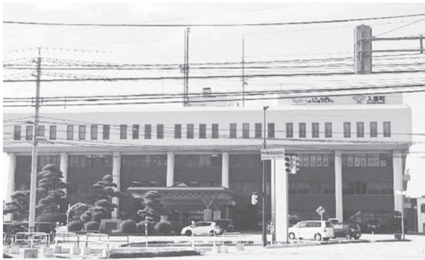
解体予定の現庁舎
