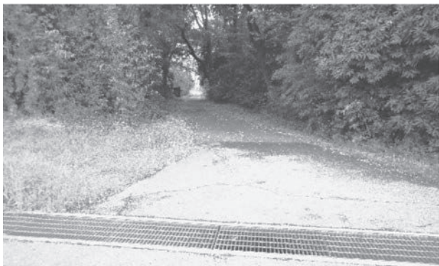
整備が計画される園家地区の道路
