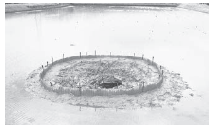
水田の陥没状況
