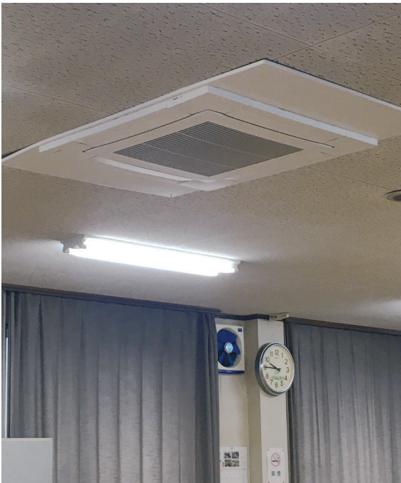
補助金を活用してエアコン修繕(入善8区公民館)
