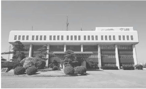
早期の解体が望ましい役場旧庁舎
