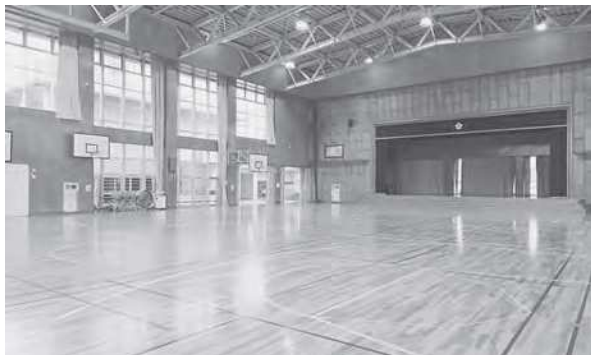
断熱調査が開始される入善小学校の体育館
