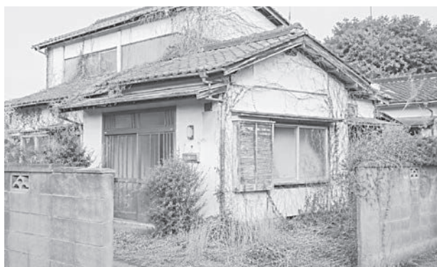
放置された空き家
