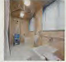
浴室リフト・天井走行型リフト (4ユニット3台)
