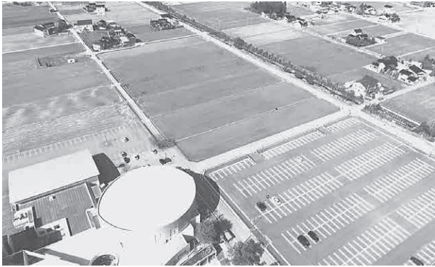
新庁舎建設予定地
