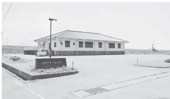
廃止された小摺戸浄化センター
