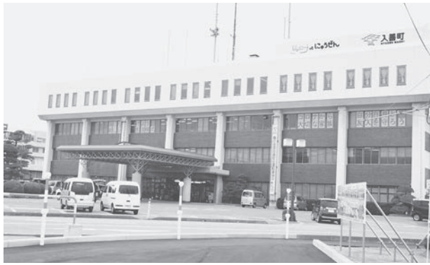
移転・建て替えの現庁舎
