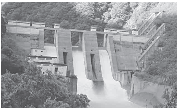
越流部から放流中の宇奈月ダム
