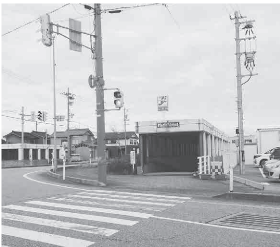
防犯カメラを設置する地下横断歩道（柗山）
