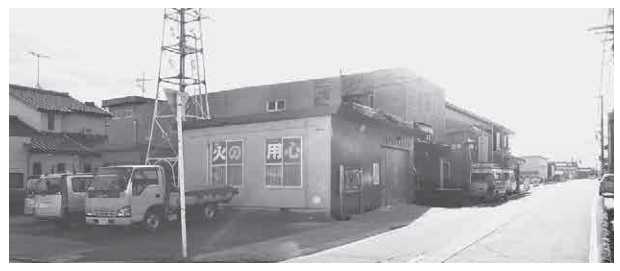
県道拡幅により移転する新屋分団屯所
