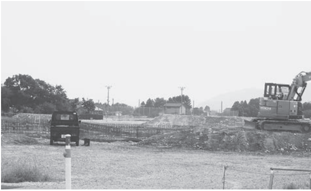
桃李総合保育所（仮称）の建設現場の様子
