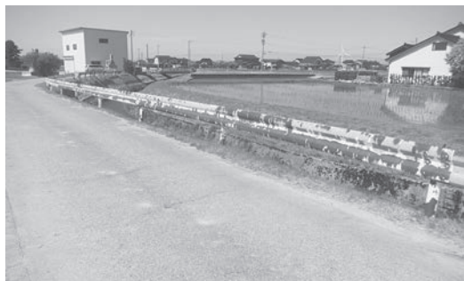
用水路の安全柵を整備
