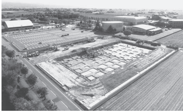
工事中の新庁舎の建設現場
