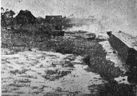
28年度に2000万円もの巨賞を投じて出来た護岸堤防も 破れ去る。吉原海岸の欠壊状況
