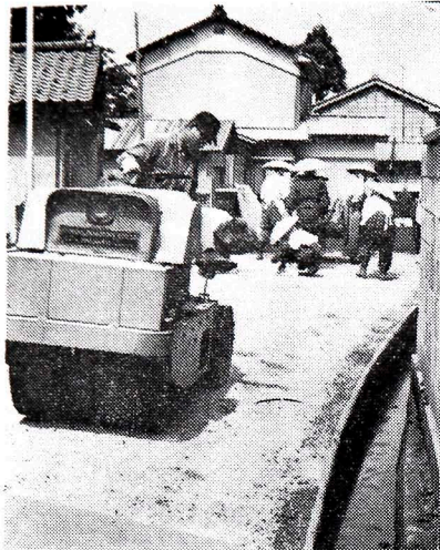
↑進む町道の舗装
