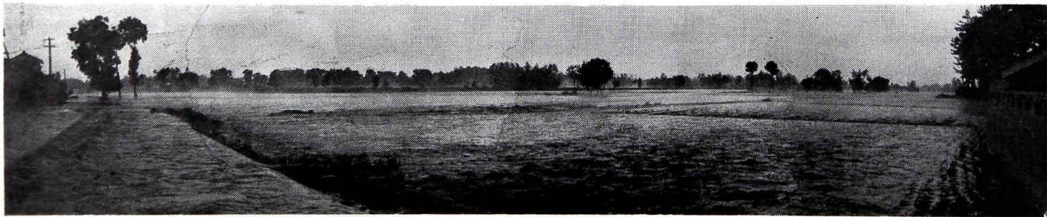
一面の川と化した旧国道東狐、上飯野間
