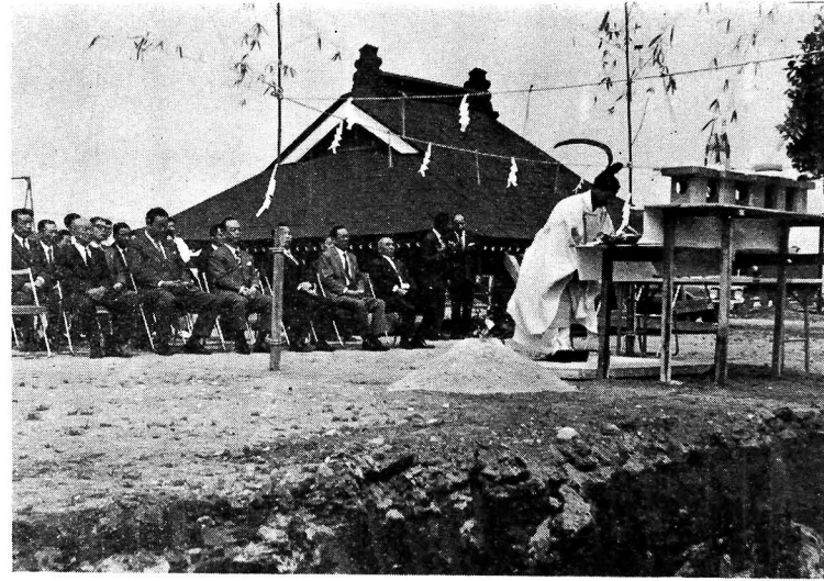
こどもたちの夢を大きくのばすためにつくられる 野中小学校プールの起工式 (4月25日)
