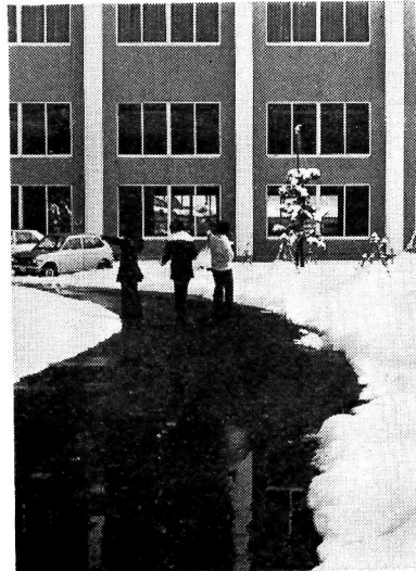
写真(上) ロードヒーティングですっかり雪のとけた福祉会館入口道路 (左) たまの出勤にハッスルの除雪車
