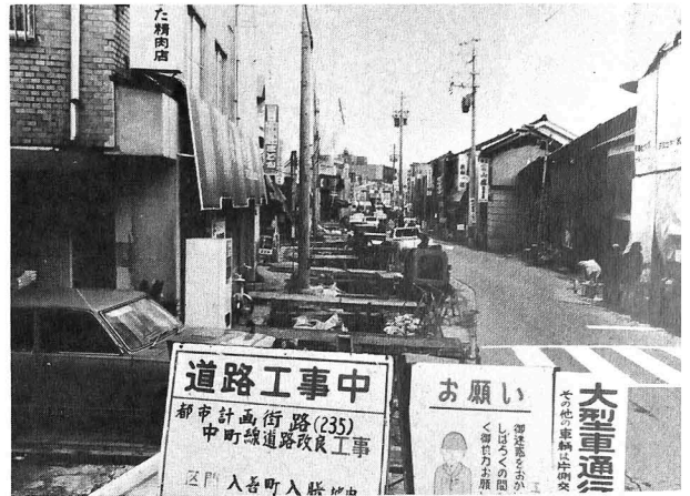
中町線の改良工事
