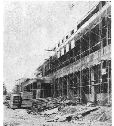
▲着々と進む上青小学校建設工事。
