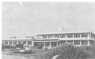
▲建設が進む上青小学校
