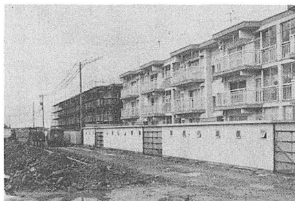
▲ 着々と進む駅南団地建設工事
