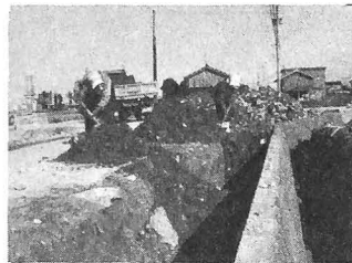
▲ 道路改良・整備
