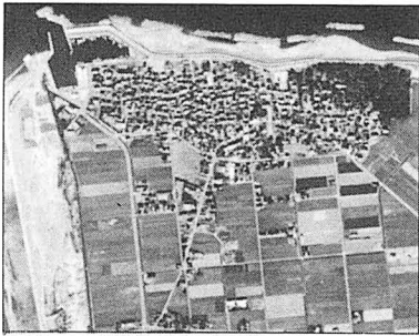
⑨ 着々と整備される芦崎地区
