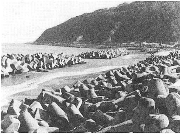
▲離岸堤の背後に移動してきた砂（朝日町・宮崎）
