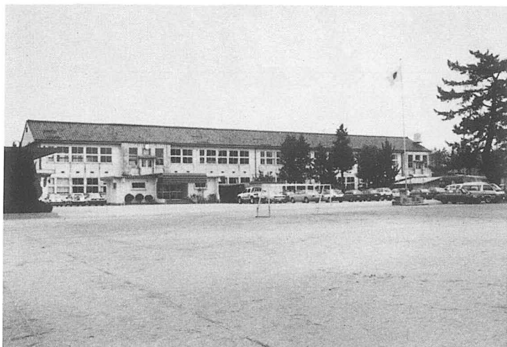
▲校舎の取り壊しは6月から始まります。
