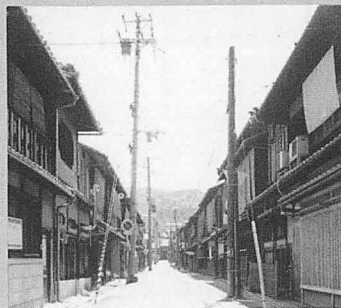
▼電線の地中化前
