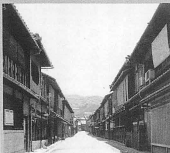
▼電線の地中化後
