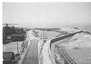
▲整備が進む入善漁港
