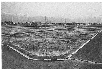
▲分譲地がいよいよ完成。申し込み者の住宅建築が始まります。
