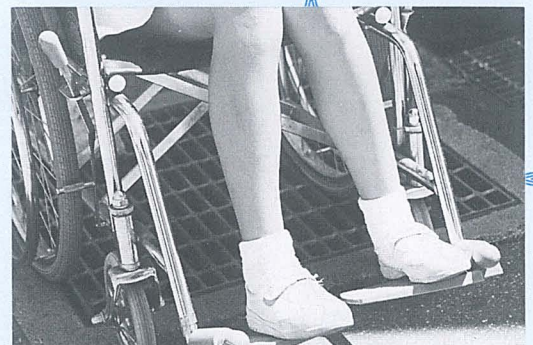
▲排水溝の網ふたにタイヤをとられて動かない。車いすに乗っている人は本当に大変なんだ。
