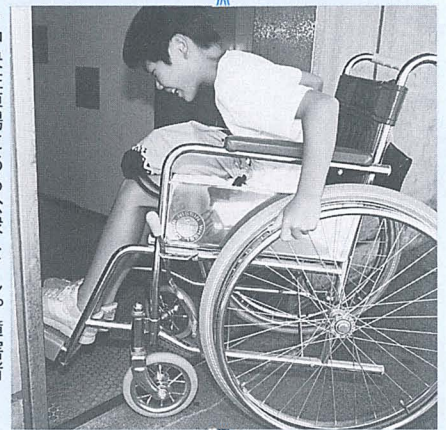
▶中央駐車場にある公衆トイレ。障害者の用のトイレはあるものの、入口が狭くてなかなか入れませんでした。
