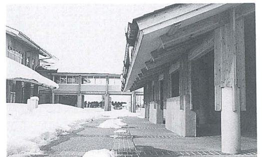
▲校舎正面のアプローチ。
