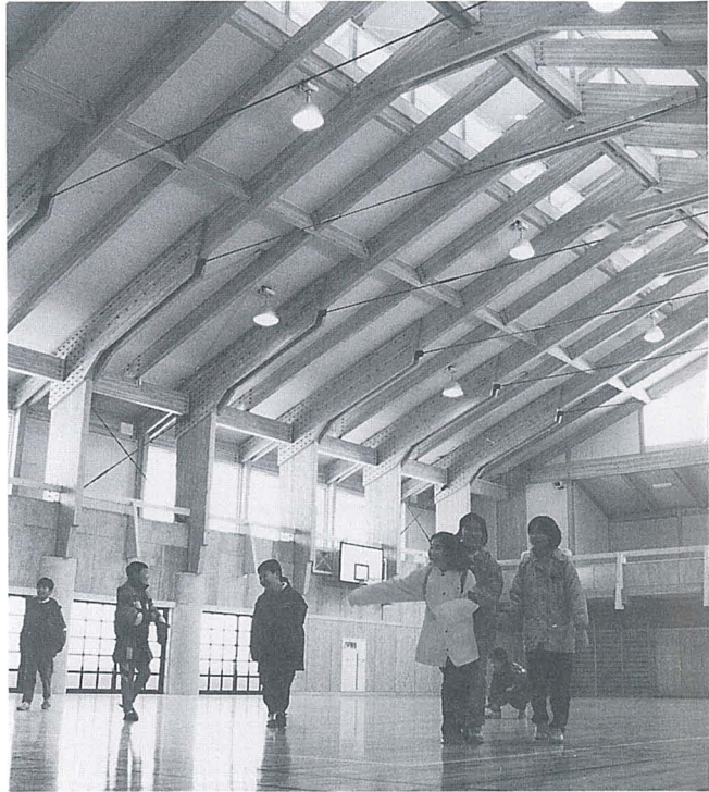
鉄筋コンクリートと木造をバランスよく組み合わせた体育館
