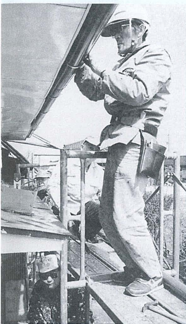
▲雨どいの修理もしっかりと。
