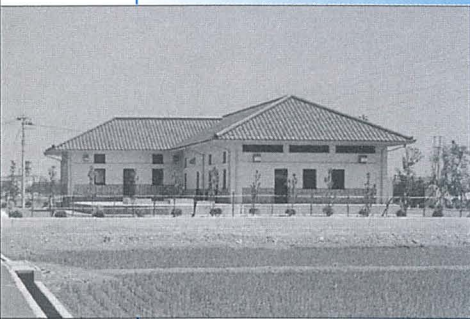
黒部市農業集落排水事業 田家地区浄化センター
