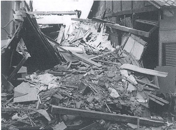
▲平成7年1月17日、阪神・淡路大震災が人々の暮らしをおそった一神戸市兵庫区の被災の様子
