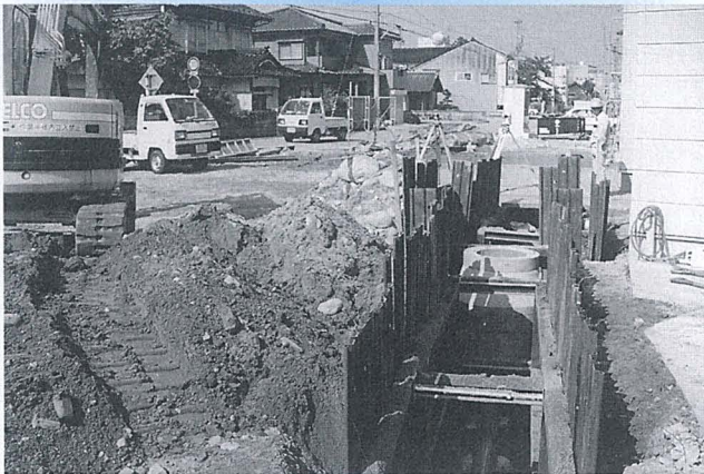
▲下水道管を埋め立てる工事現場
