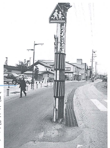
▲道の真ん中に建つ電信柱 — 商工会館前で —
