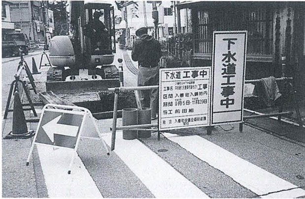
▲いよいよ本格的に始まる下水道整備 — 中央通り線では、8年度に下水管を埋設 —
