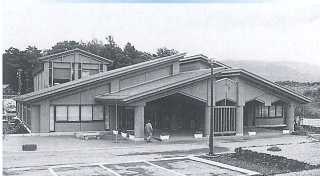
▲使用を開始したばかりの浄化センター（長野県御代田町・御代田浄化センター）。地域の環境に溶け込む施設建設を目指します。
