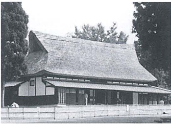
▲移築保存工事が進む「山の本陣」
