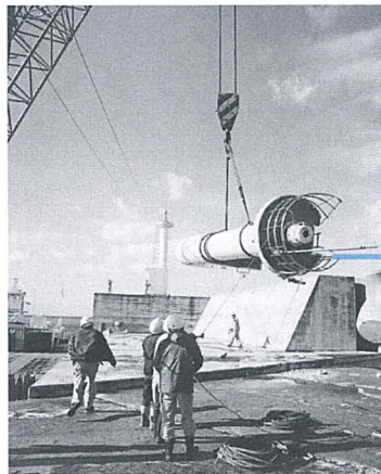
▲大型クレーンで撤去される旧灯台 —入善漁港で—
