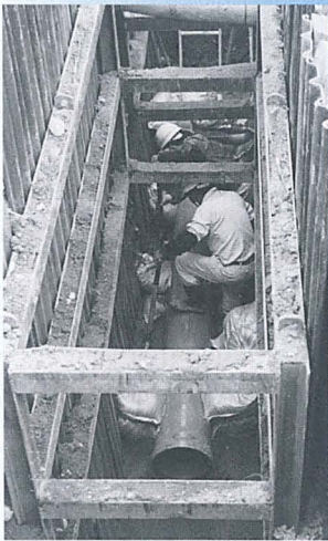
▲下水管の埋め立て工事-田中地区で-
